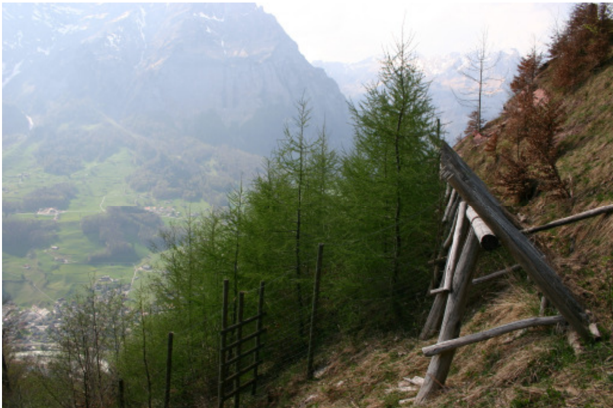
Schutzwaldaufforstung mit Lärche, Lawinerverbauung, Sturmfläche Holzport, April 2010
